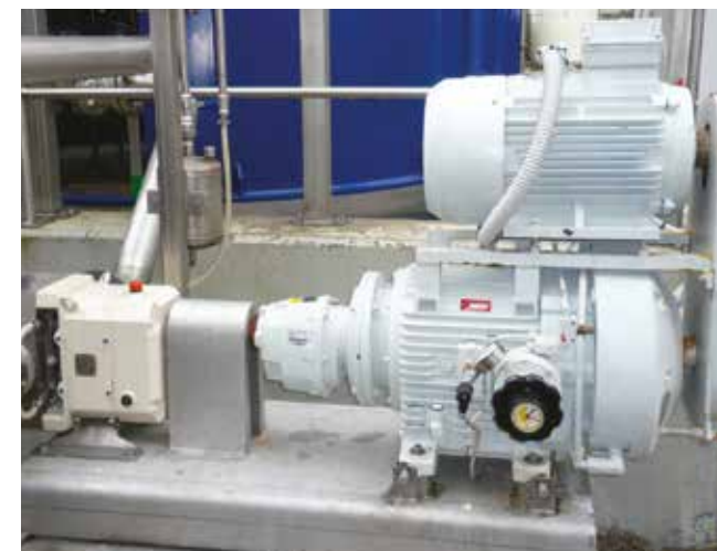
Instalación de tratamiento de residuos: aplicación a cielo abierto con bomba de lóbulos, unidad de 11 kW con motor superpuesto
